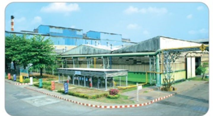
โรงงานสระบุรี
