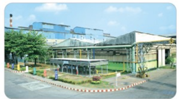
โรงงานสระบุรี
