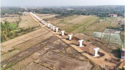
โครงการก่อสร้างรถไฟทางคู่ สายเด่นชัย-เชียงราย-เชียงของ
